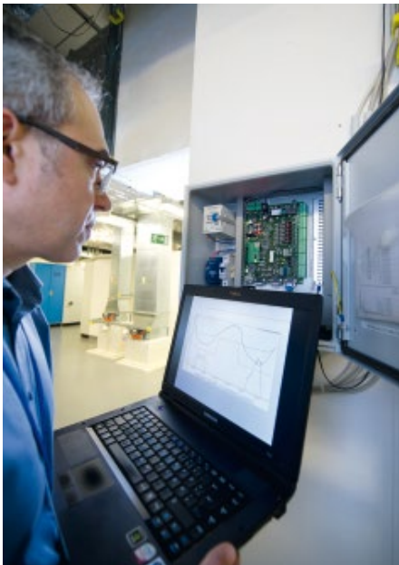
Abb. 1: Inbetriebnahme des zentralen Datenerfassungsmoduls in der Lüftungszentrale
