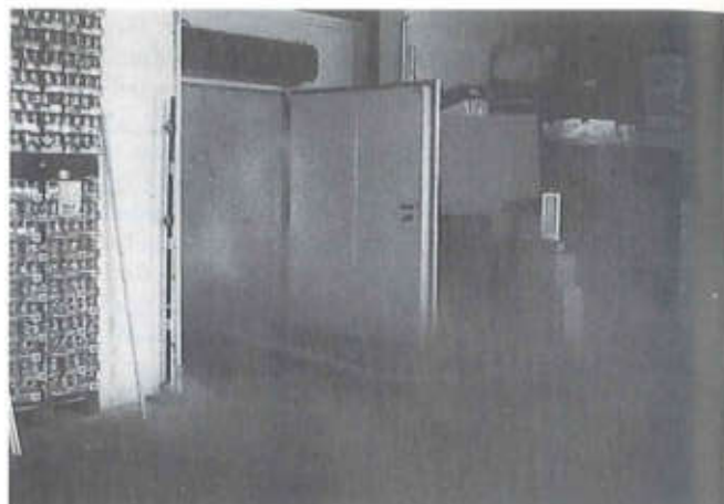
Bild 10: Einbringung von Nebel in der Kühlzelle in ca. 2 m Abstand von der Tür; bei eingeschalteter Torschleieranlage (Aufnahme ca. 90 s nach Türöffnung)
